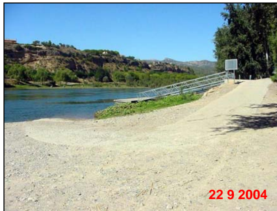
Acceso a rampa
