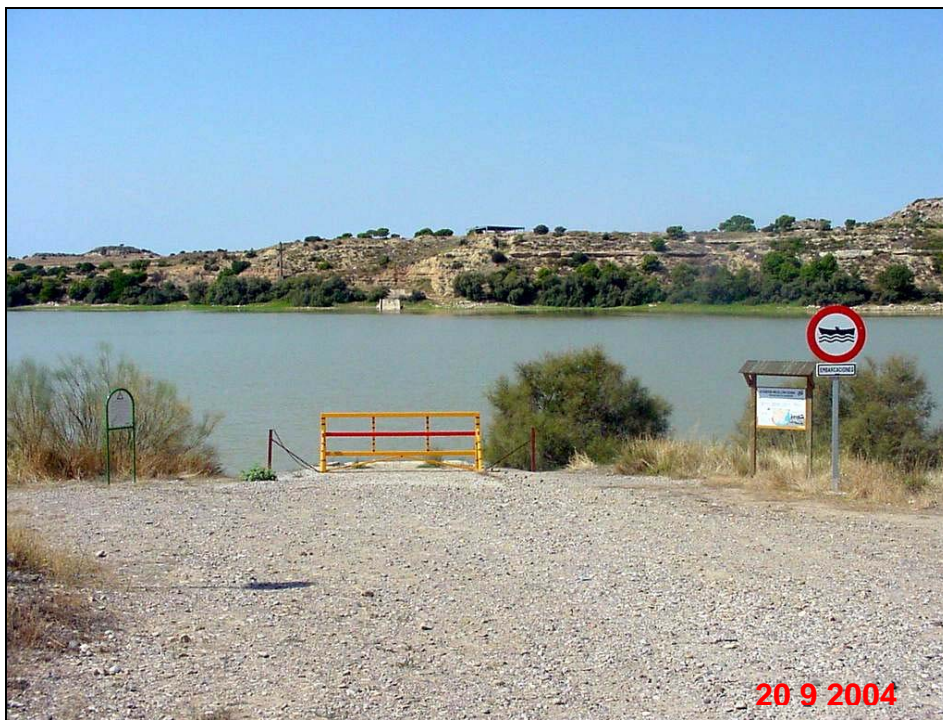
Acceso Cortado y señalizado.
