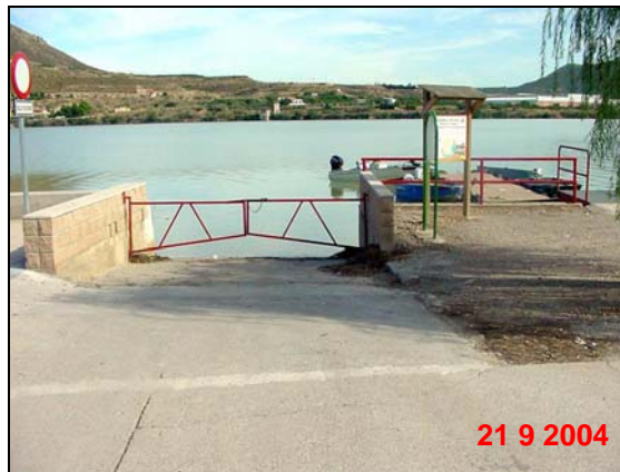
Acceso a rampa
