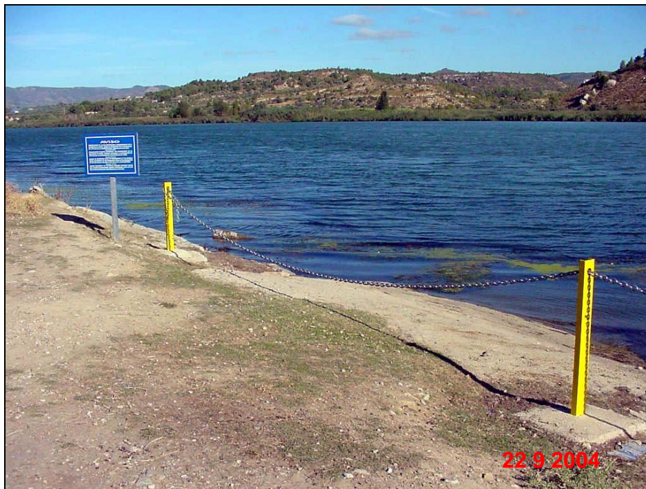
Señalización y rampa con cadena
