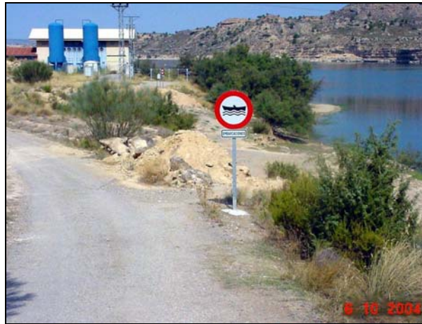
1. Acceso Cortado y señalizado.
