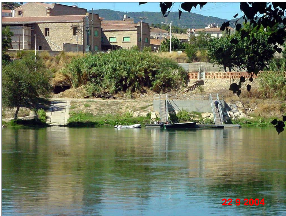
Rampa y embarcadero.
