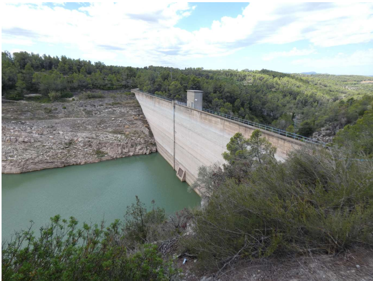
Embalse de Guiamets en el río Asmat el 3/8/2023 que no pudo atender a los regadíos de la Comunidad de Regantes del Baix Priorat
