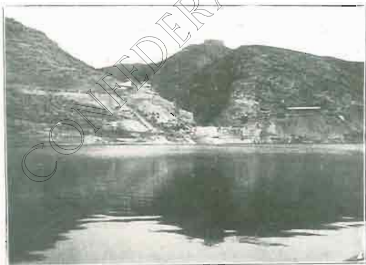
Vista parcial del embalse. — Al fondo la presa y las instalaciones de machacadoras, molinos y hormigoneras.
