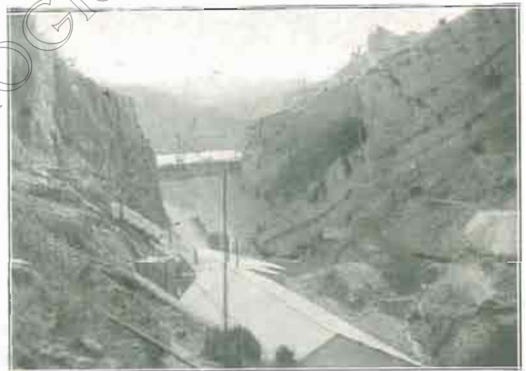
Vista del paramento de aguas abajo de la presa y de los pabellones para motores y talleres.
