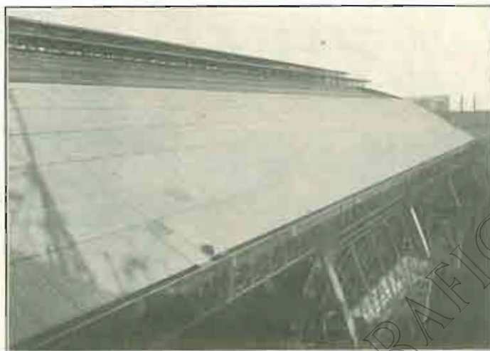
Faves de la nueva estación de M. L. A. de Barcelona, cubiertas con URALITA CANALETA
