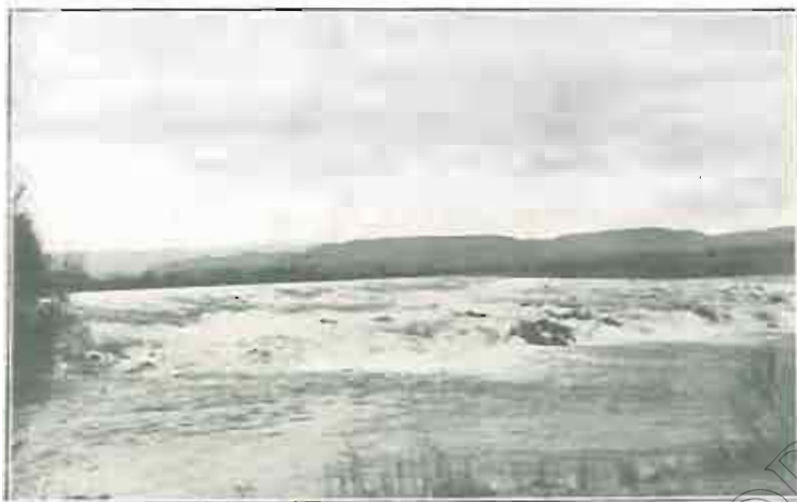
Presá en el Ebro para la toma de agua del Canal Victoria-Alfonso
