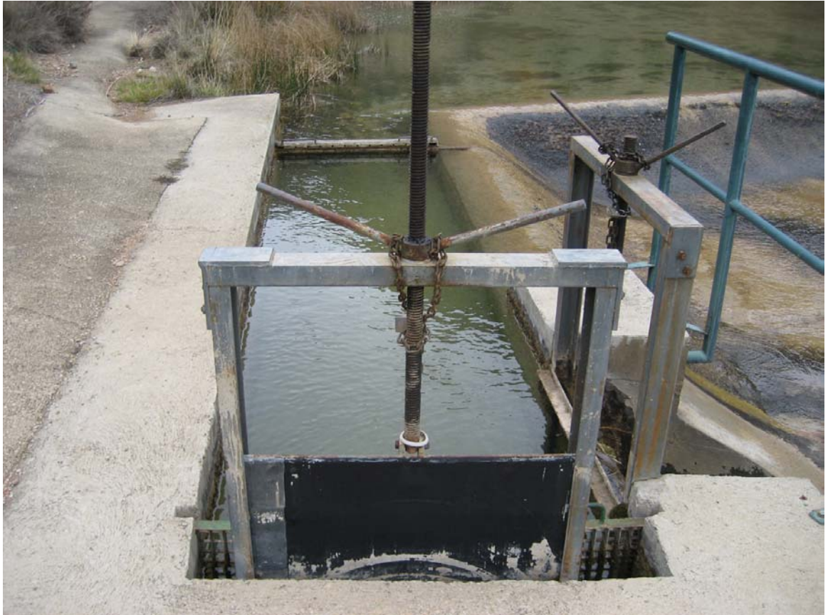
Ref. 19.- Azud para la toma intermedia de abastecimiento a Huesca: detalle de la entrada de agua.
