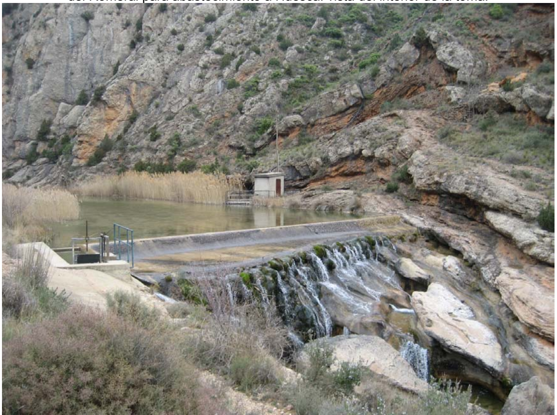
Ref.18.- Azud para la toma intermedia de abastecimiento a Huesca: vista general del azud.
