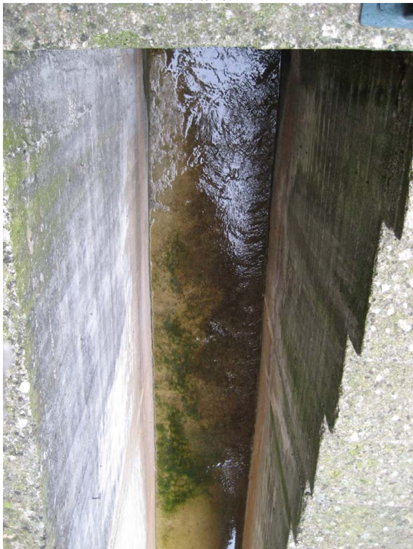
Ref. 10.- Toma de agua para abastecimiento a Huesca: detalle del aliviadero.
