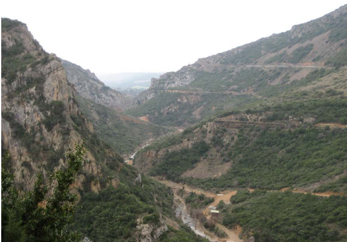
Ref. 13.- Vista panorámica del río Guatzalema aguas arriba de la localidad de Santa Eulalia La Mayor dónde se observa el canal de abastecimiento a Huesca.
