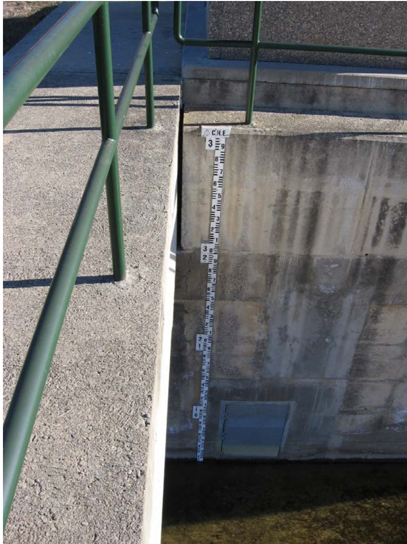
Ref. 45.- EA N° 32 del río Guatizalema en Peralta de Alcofea: vista general de la estación de aforos.
