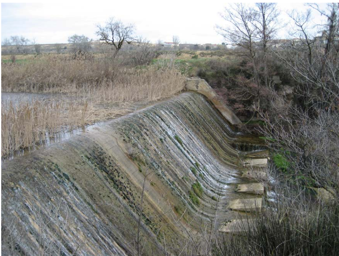
Ref. 32.- Azud de la acequia de Argavieso utilizada para riego y que nace en la margen izquierda del río Guatizalema a su paso por la localidad del Pueyo de Fañanás.
