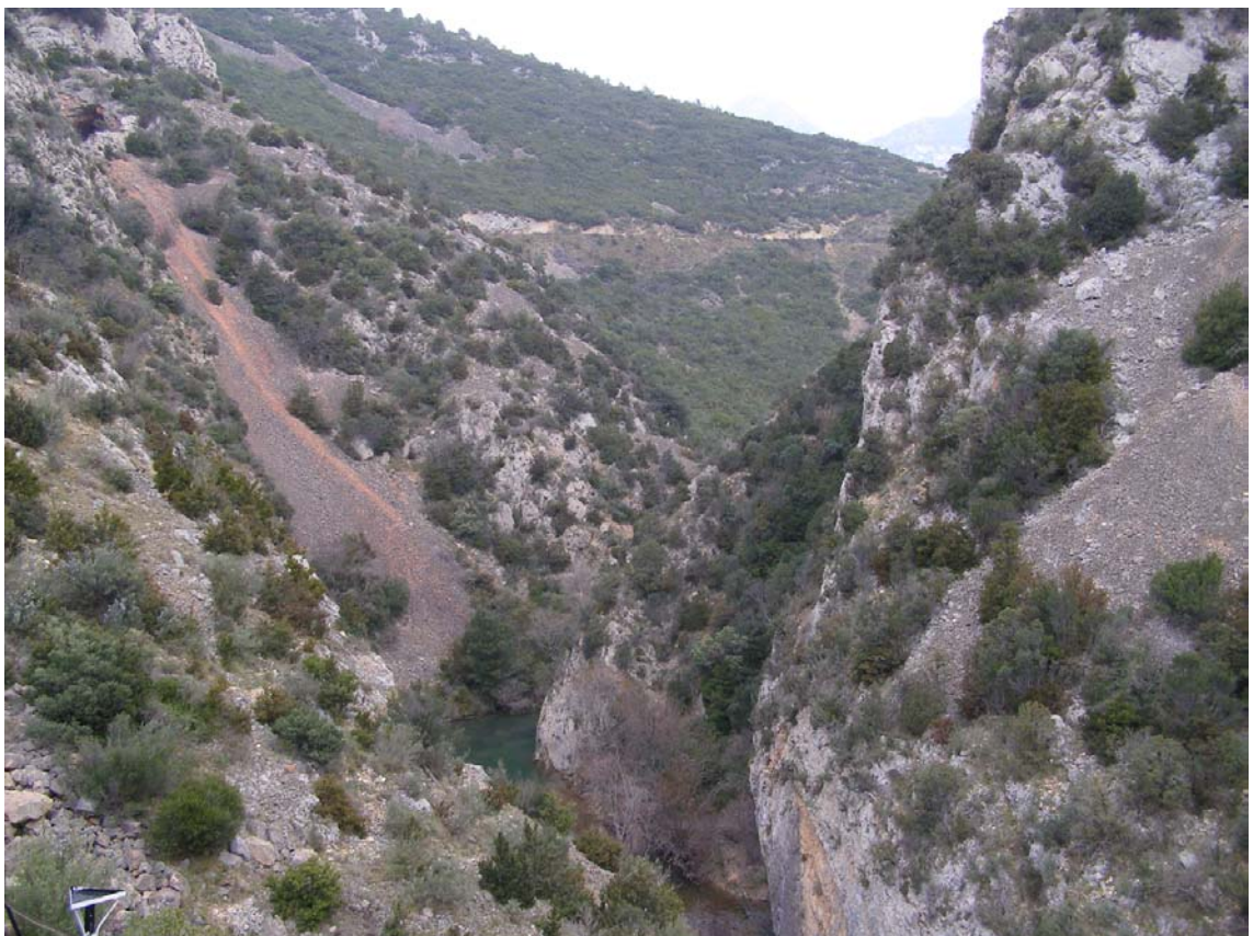
Ref. 6.- Toma de agua para abastecimiento a Huesca: aspecto del río Guatzalema aguas arriba de la toma.
