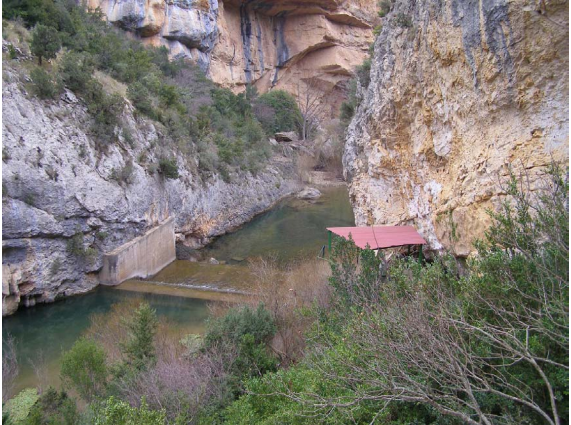
Ref. 7.- Toma de agua para abastecimiento a Huesca: vista general de la toma.
