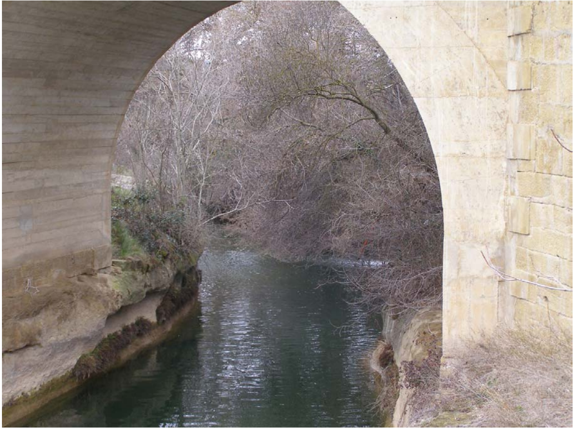
Ref. 23.- EA N° 192 del río Guatizalema en Siétamo: aspecto del río Guatizalema aguas arriba de la estación.
