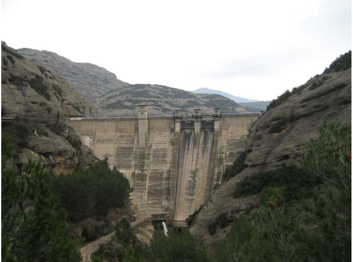
Ref. 1.- Embalse de Vadiello: vista general de la presa.
