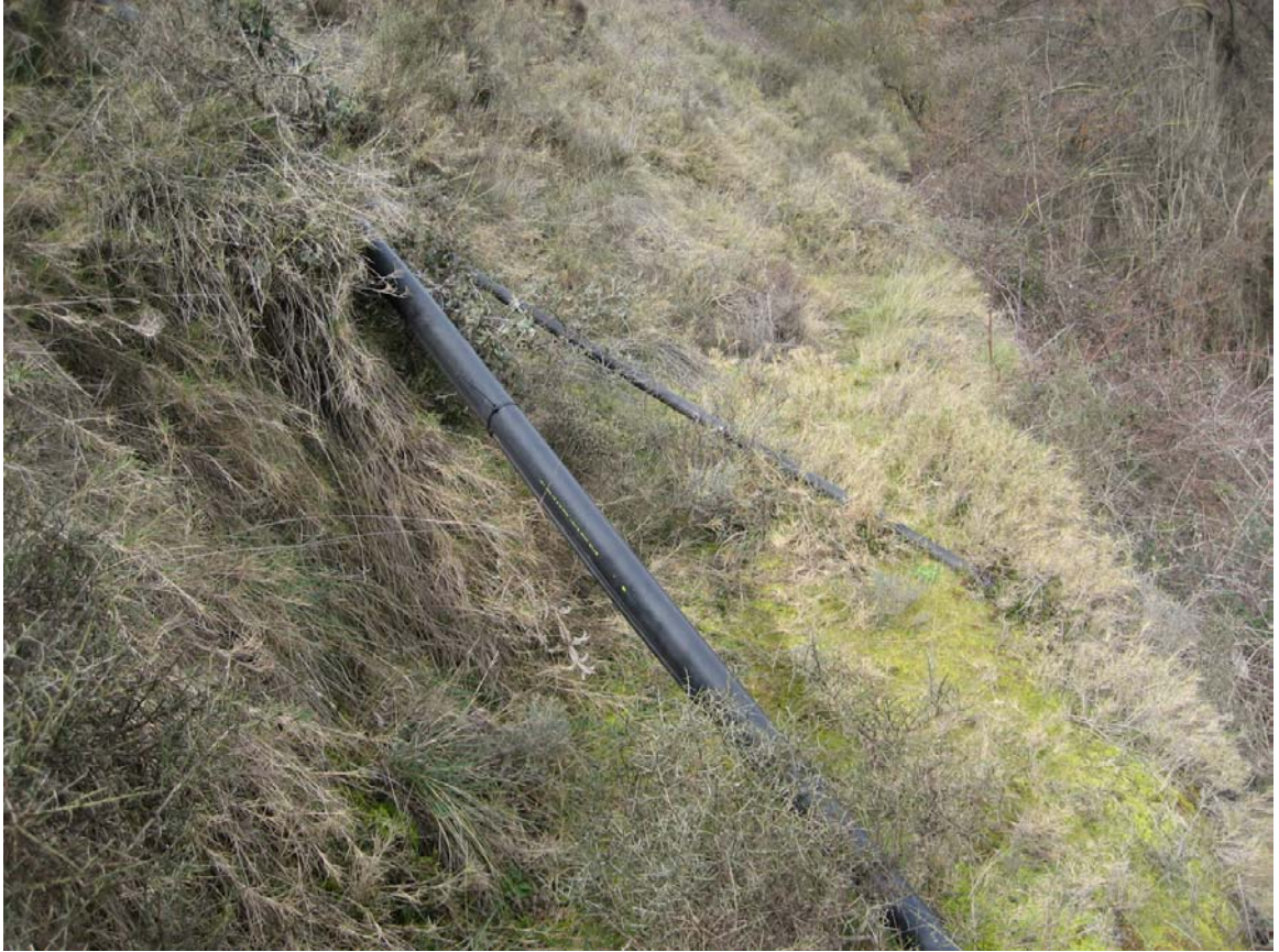
Ref. 27.- Vista de las tuberías de toma de agua para granjas situadas aguas abajo del azud de la acequia de Abrisién.
