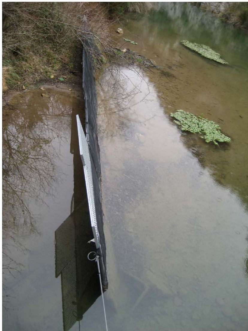
Ref. 8.- Toma de agua para abastecimiento a Huesca: detalle de la entrada de agua.
