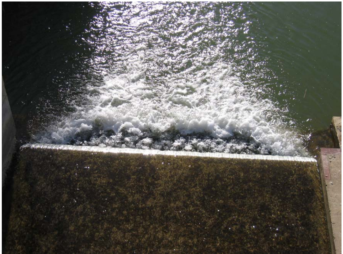
Ref. 46.- EA N° 32 del río Guatizalema en Peralta de Alcofea: detalle de la sección de paso.
