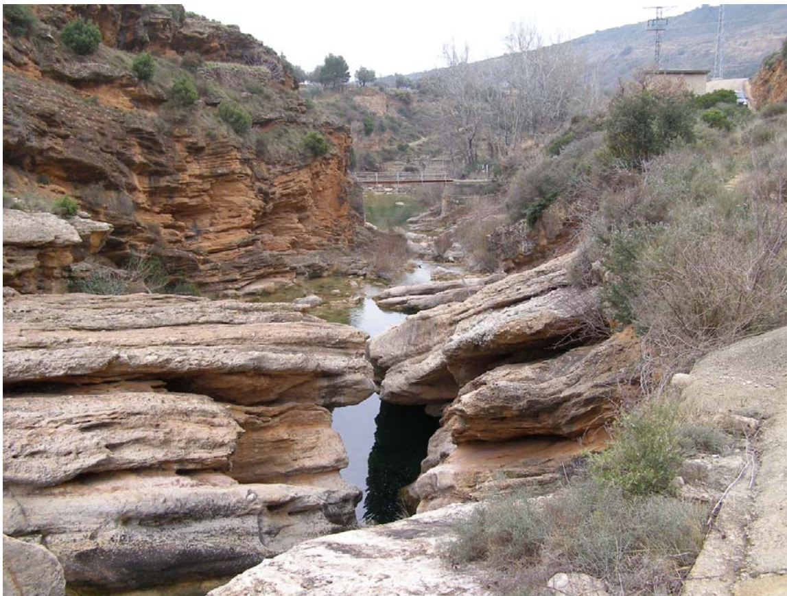
Ref. 21.- Azud para la toma intermedia de abastecimiento a Huesca: aspecto del río Guatzalema aguas abajo del azud.
