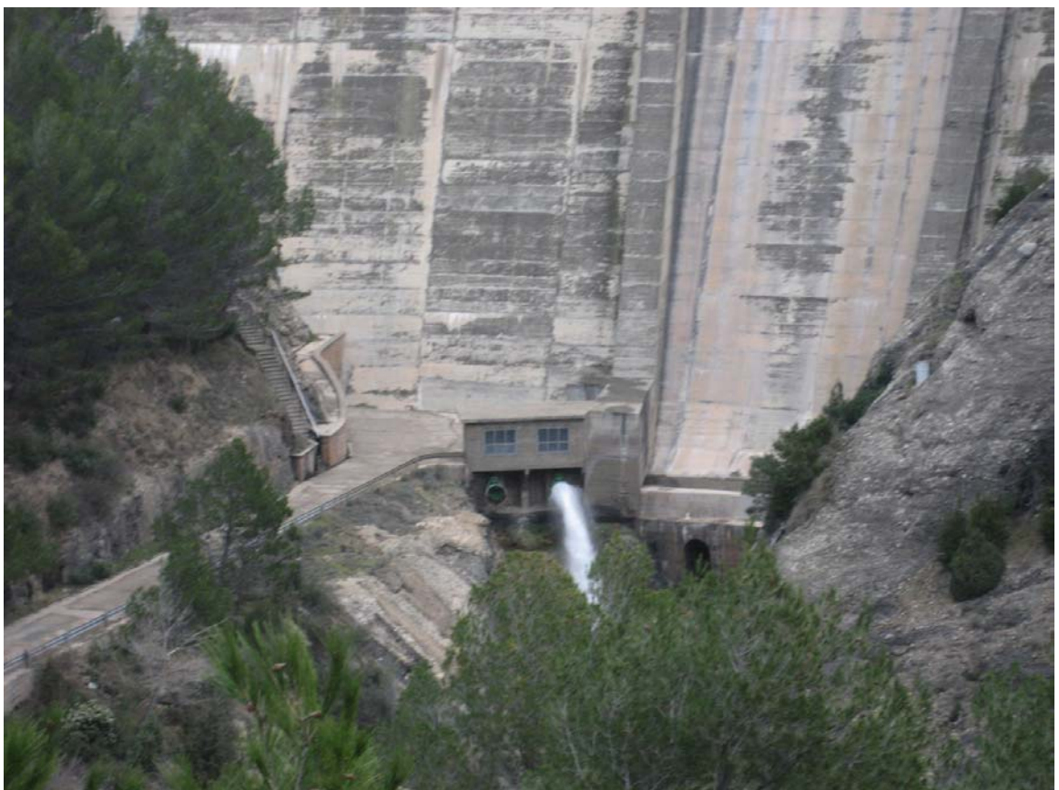
Ref. 2.- Embalse de Vadiello: detalle del desagüe de fondo.
