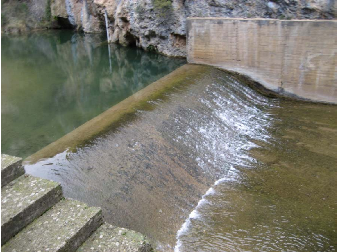
Ref. 11.- Toma de agua para abastecimiento a Huesca: vista del azud.
