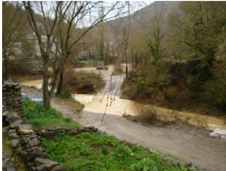
Imagen 2: Detalle de barrancada sobre vado sin asfaltar que aísla a parte de la población de Montañana
