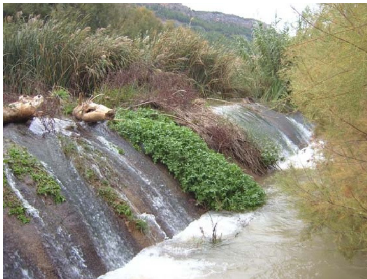
Fig. 6. Vista del obstáculo desde aguas abajo
