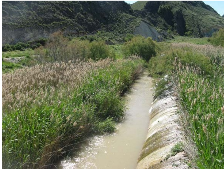
Fig. 5. Vista del obstáculo desde la margen izquierda
