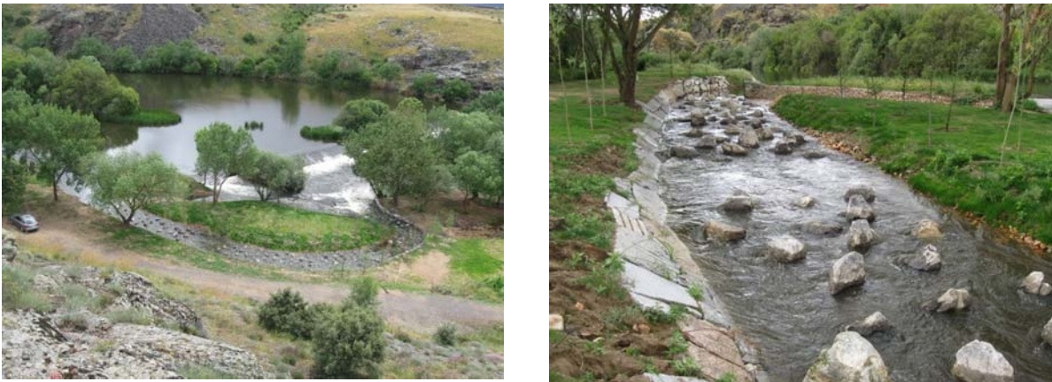
Fig. 8. Río artificial en el río Tormes, cuenca del Duero (izquierda) y detalle del interior (derecha) Fuente: F.J. Sanz Ronda
