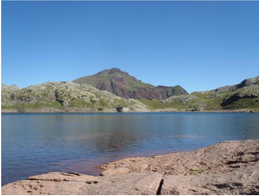
Presencia de estructuras artificiales en la cubeta
