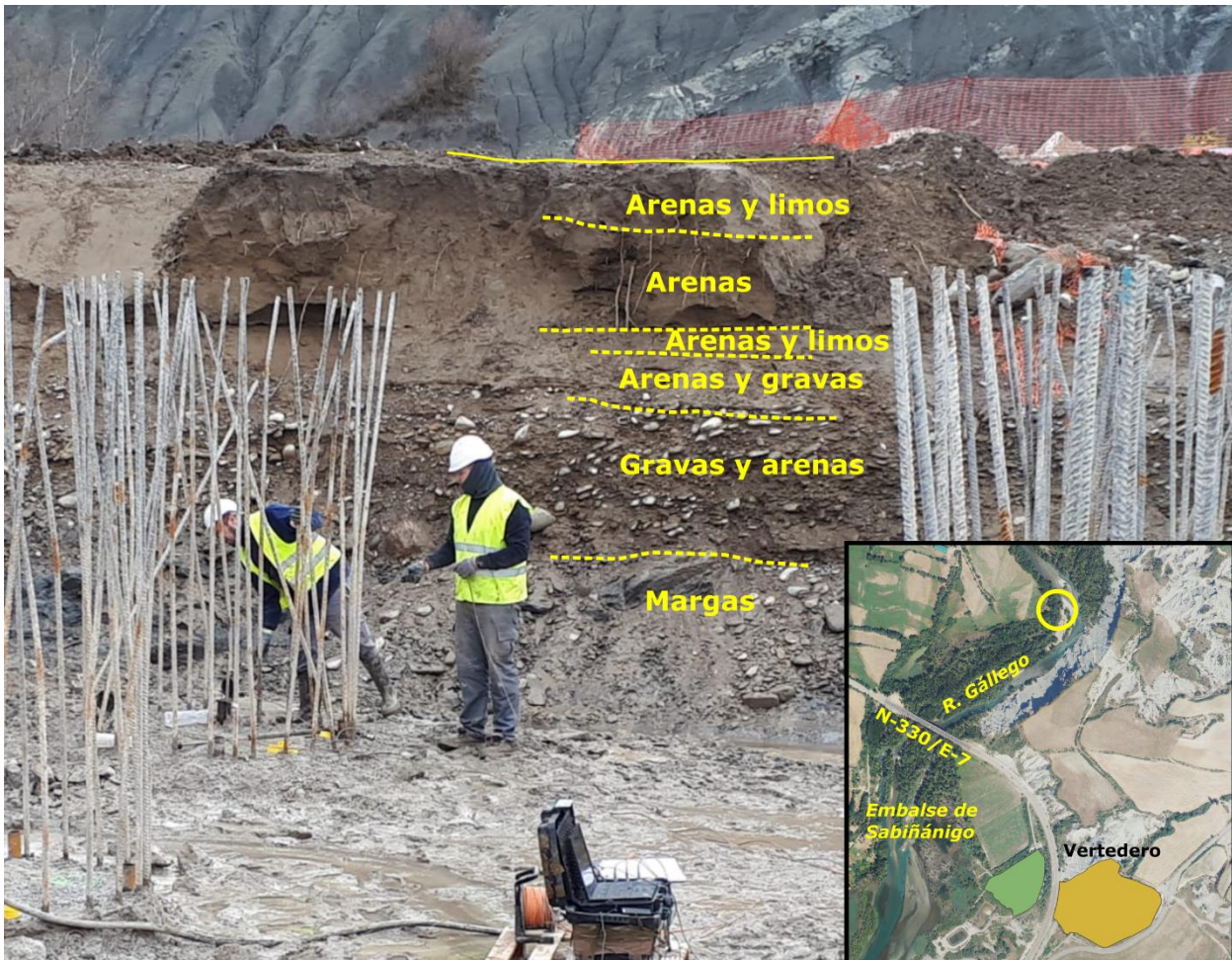
Figura 17. Materiales cortados en las excavaciones realizadas para las pilas del viaducto de la autovía A-23. (Fotografía cedida por la Demarcación de Carreteras del Estado en Aragón).
