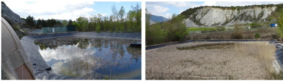
Figura A10.6. Balsas de lixiviados de nueva (izquierda) y antigua (derecha)
