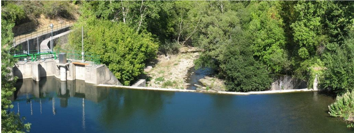
Figura 21-7. Azud de derivación al embalse de González Lacasa.
