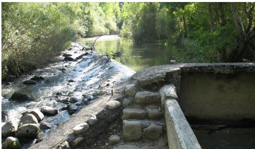
Figura 21-14. Azud de derivación de caudales.
