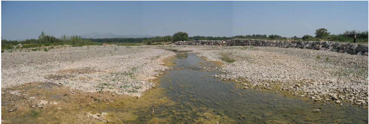
Figura 21-19. Cauce y defensas en el tramo bajo del cauce del Iregua.
