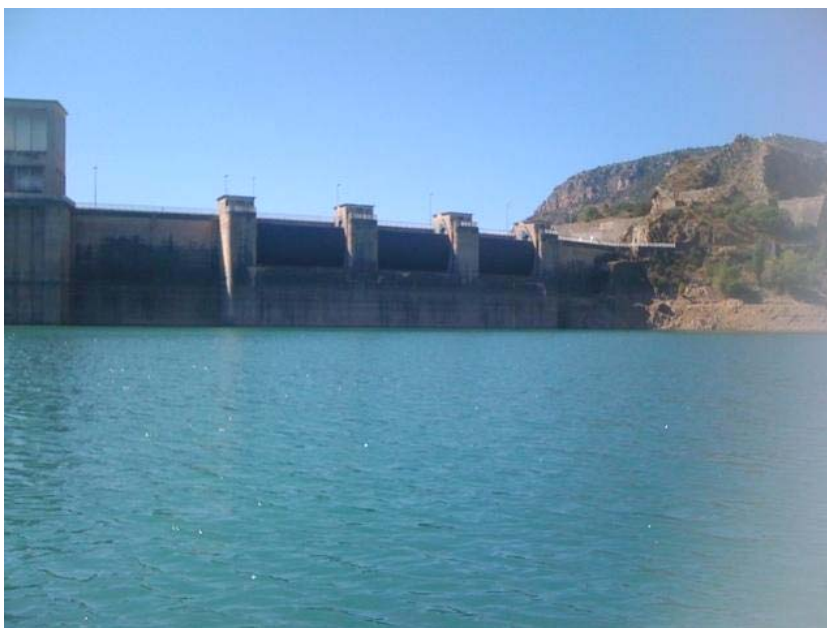
Foto 1: Vista general del embalse
