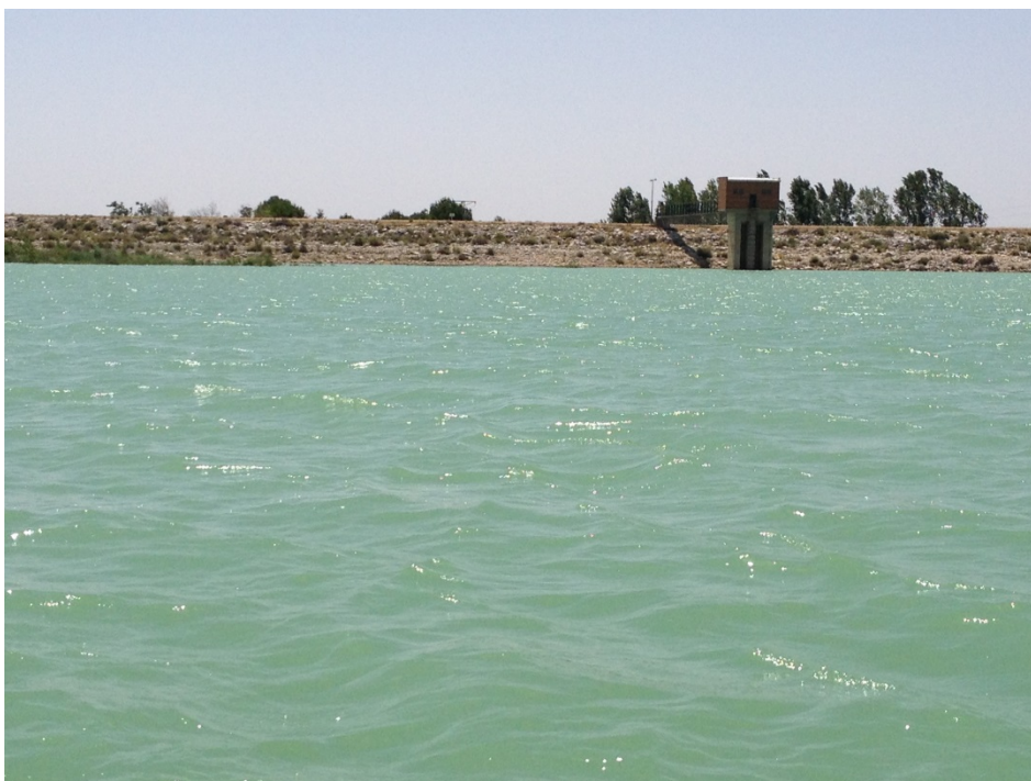
Figura 7. Vista de la presa del embalse.
