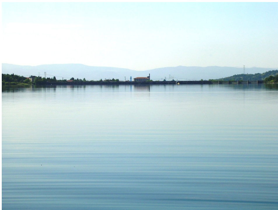
Figura 7. Vista de la presa del embalse
