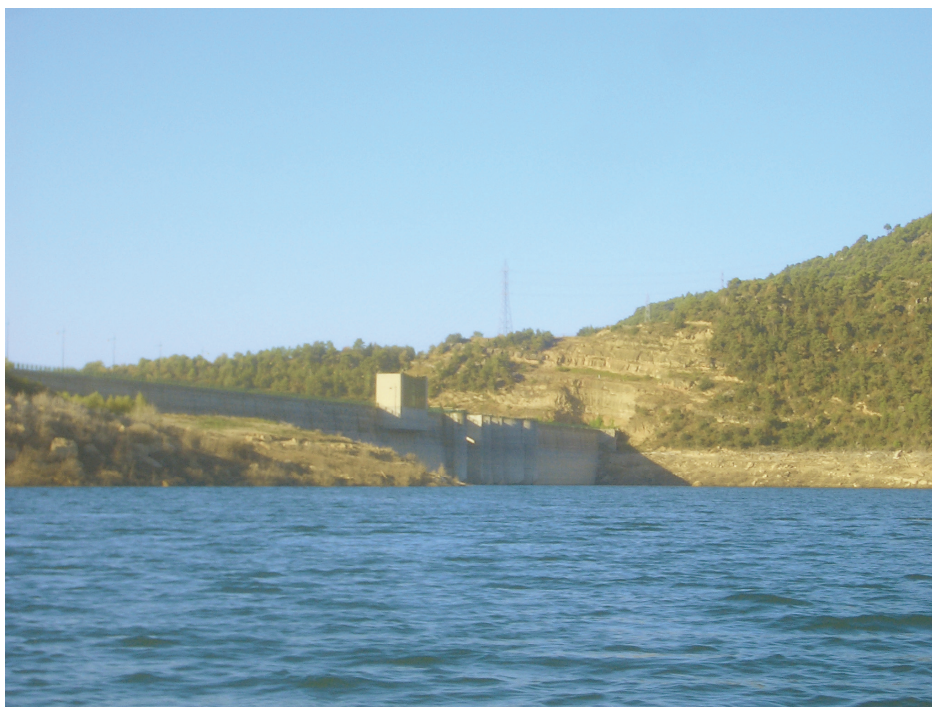
Foto 1: Vista general de la presa del embalse
