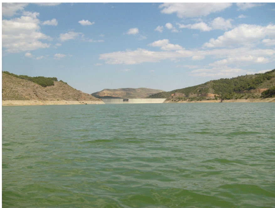
Foto 1: Vista de la presa del embalse
