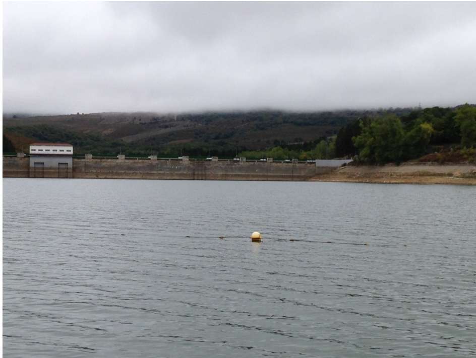
Figura 7. Vista de la presa del embalse
