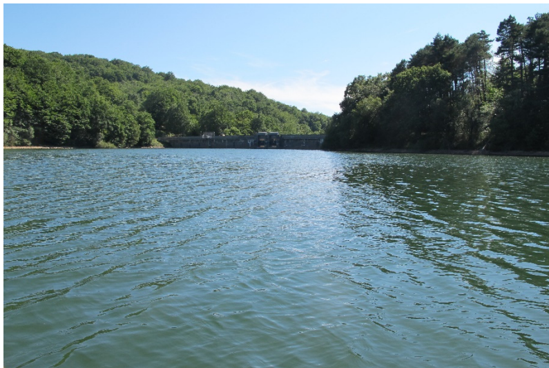
Figura 7. Vista de la presa del embalse.
