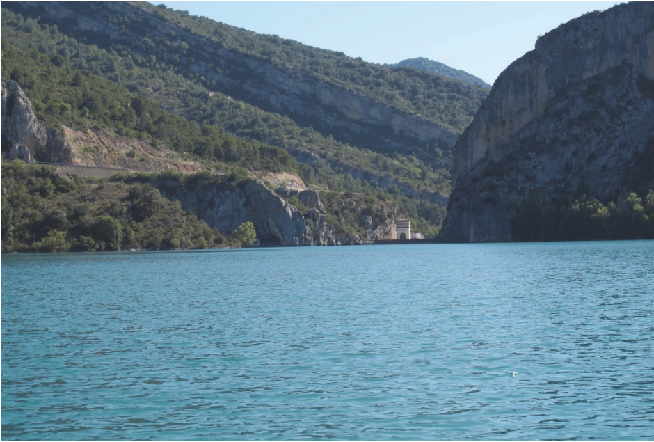
Figura 7. Vista de la presa del embalse
